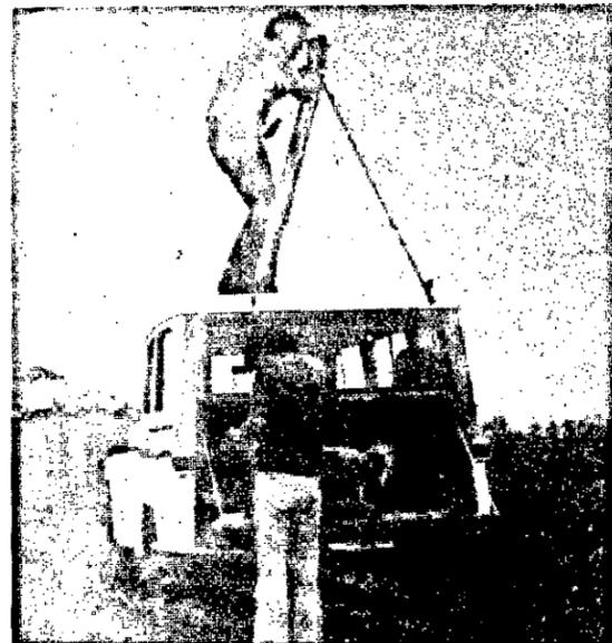
Levantamentos topográficos para a obtenção de perfis de cada lance.
