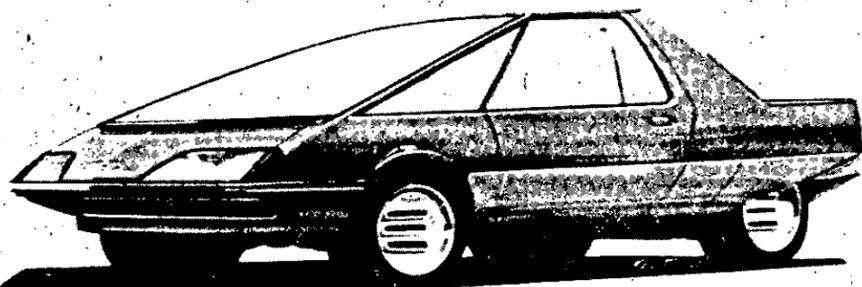
Engenheiros da Ford Alemã estão desenvolvendo novos modelos, com nova aerodinâmica, baixo custo e pequeno consumo de combustível. Inicialmente estão desenvolvendo este pequeno veículo (foto), com dimensões padrões, que podem ser transformados em vários modelos, com o mínimo de despesas. Usará motor transversal de 4 cilindros entre 10/50 HP capaz de desenvolver a velocidade máxima de 140 km/horários.
